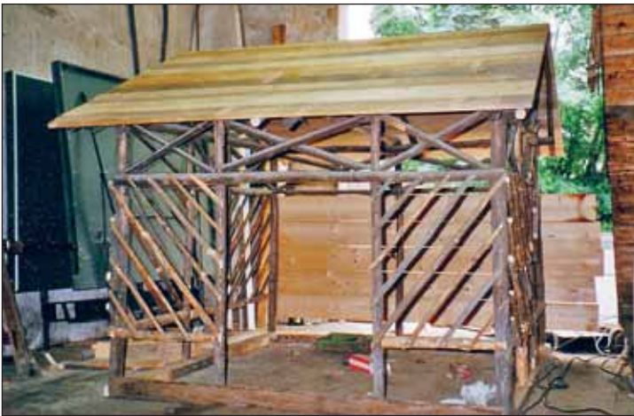
Sanierung vom Winter bis Sommer 1998.
