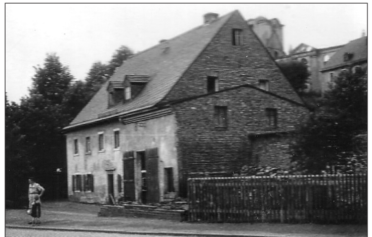
Das wieder aufgebaute Wohnhaus mit Beschlagschuppen 1952. Das sich vormals
