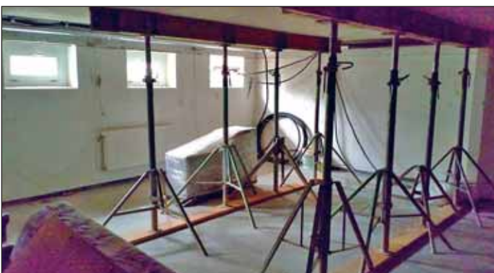
Der ehemalige Bandraum Anfang November ohne Holzdecke und Instrumente...
