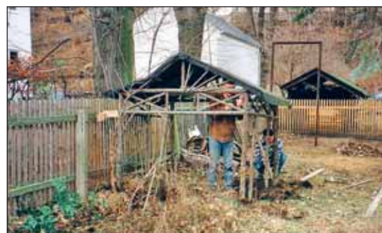
Kein Abriss, sondern der Abbau im Dezember 1997.
