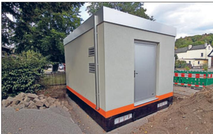
seren Standort gibt's dafür nicht, täuscht sich. Wir kommen gleich dazu. Anfang September 2019 wurde die PoP-Station via Kran auf das vorgefertigte Fundament gehoben. Die Anschlussarbeiten, also die ganze Verkabelung, gingen bis in den Sommer 2020. Längst ist die Anlage in Betrieb.
